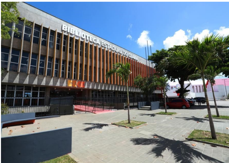
Figura 1 - Fachada da BECE após reinauguração
