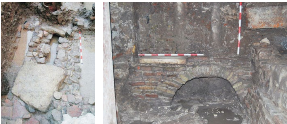
Figura 20. Canalización con cubierta. Figura 21, colector
