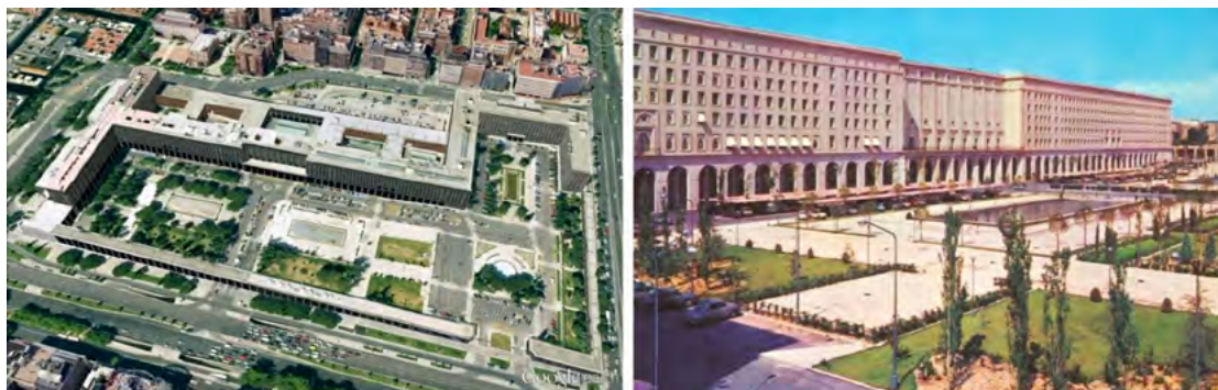
Fig. 4.—Conjunto Nuevos Ministerios, Madrid. Imagen aérea (izquierda) y postal, 1985 (derecha). Fuentes: Google Earth y MITMA.
