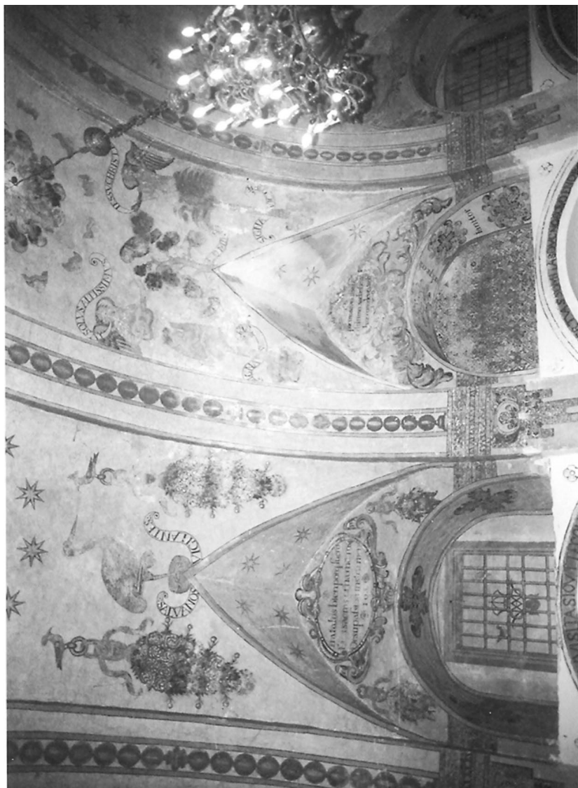
Fig. 1: Aspecto general de la decoración de la bóveda de la sacristía.
