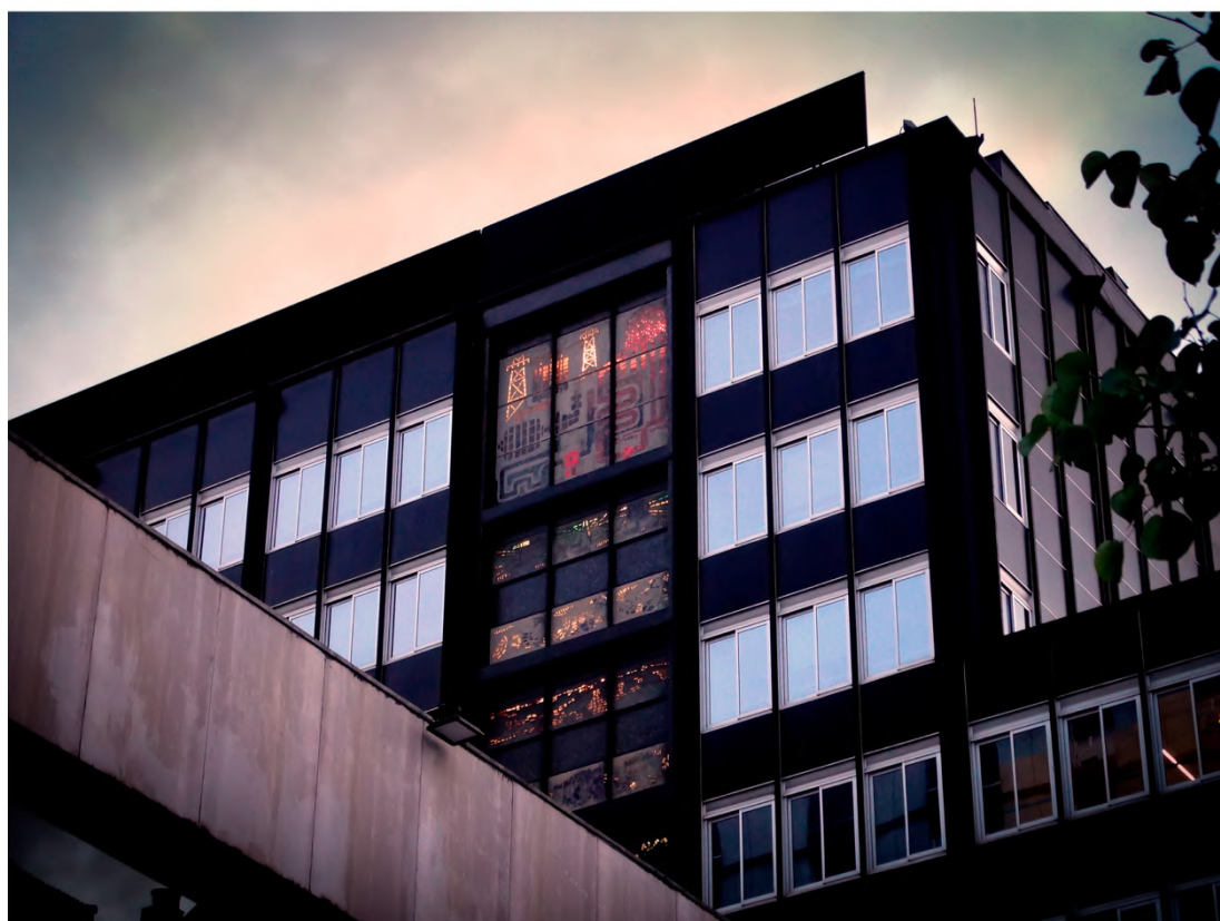
Fig. 2. Fachada posterior (arriba) y detalle de las vidrieras (abajo) de la Sede Social de Hidroeléctrica del Cantábrico. Fotos: el Autor.
