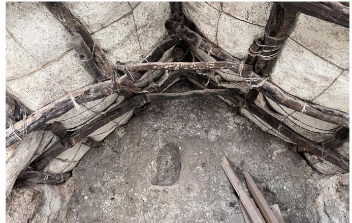
Figura 2. Cielo interior de una vivienda tradicional en Guallatire, "caruna" o "takta", el material en estudio en color blanco, fotografía año 2022. Fuente: Elaboración de los autores
