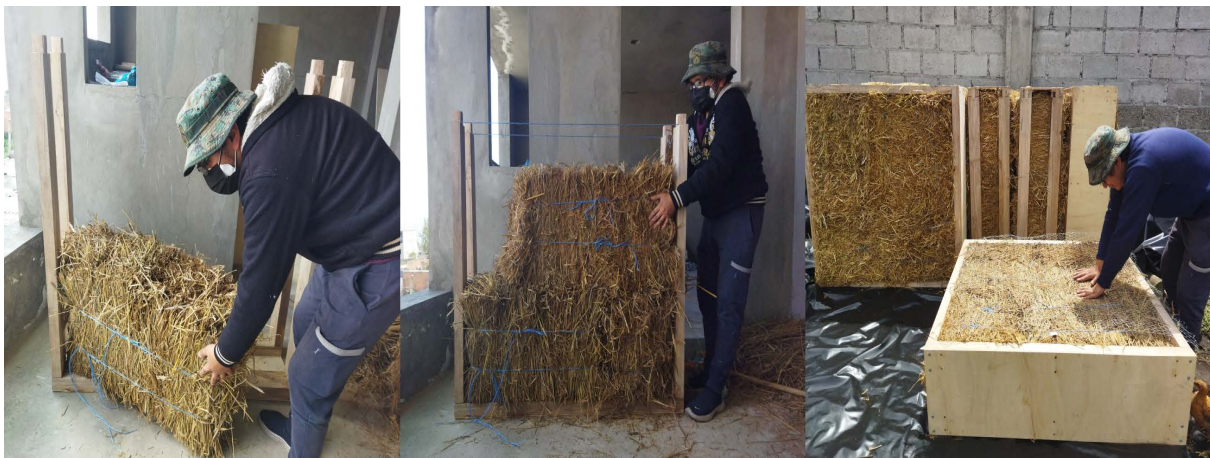
Figura 10. Construcción de paneles Fuente: Elaboración de los autores.
