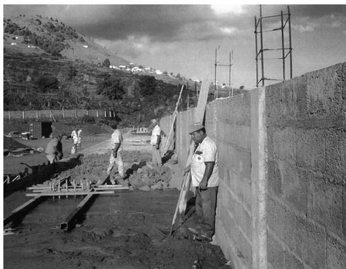
Preparación de la grada este; pese a su menor aforo, debido a su ubicación sobre la muralla de nivelación y la instalación de las torres de luz, se trató de una de las obras más laboriosas [MSB]
