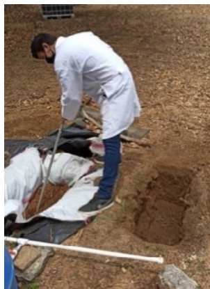
Figura 9. Construcción de las dos barreras reactivas permeables.
