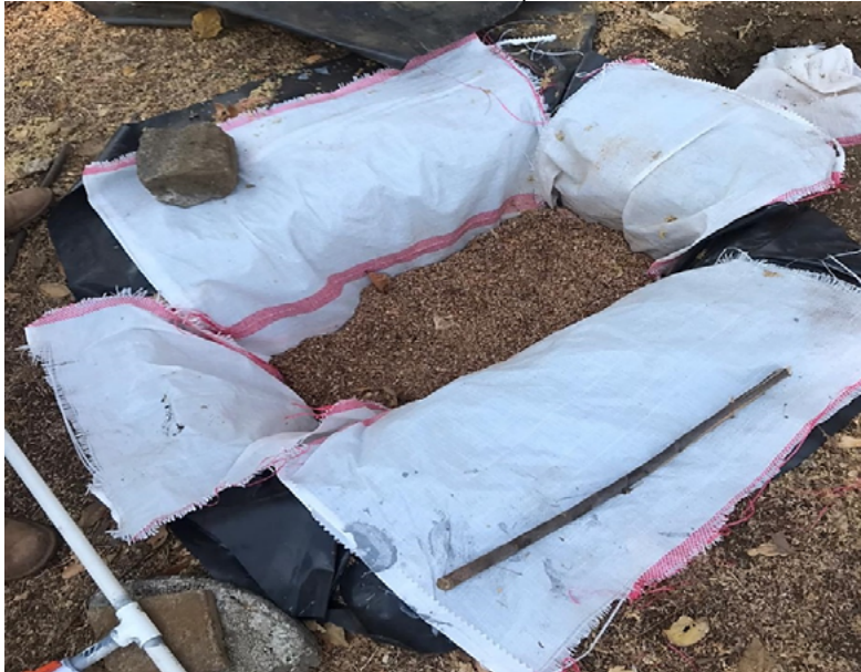
Figura 10. Vista lateral, Barrera reactiva permeable llena con aserrín.
