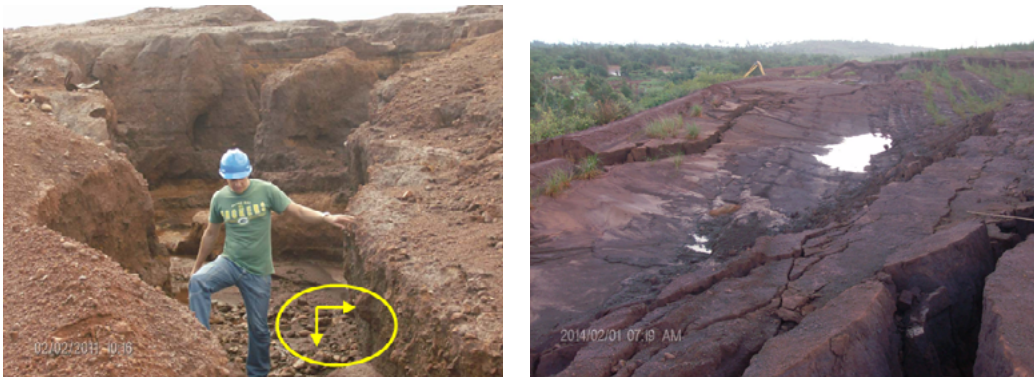
Figura 4 a). Cárcava de gran magnitud en la zona C. b) Deslizamiento en diques de la zona D
