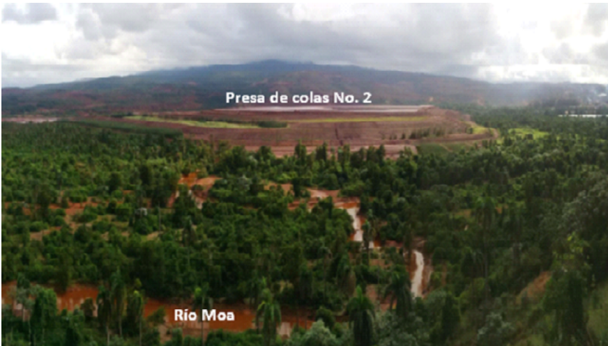
Figura 1. Presa de colas No. 2. Nota: La presa fue construida sobre el valle aluvial del río Moa. Fuente: Autores.
