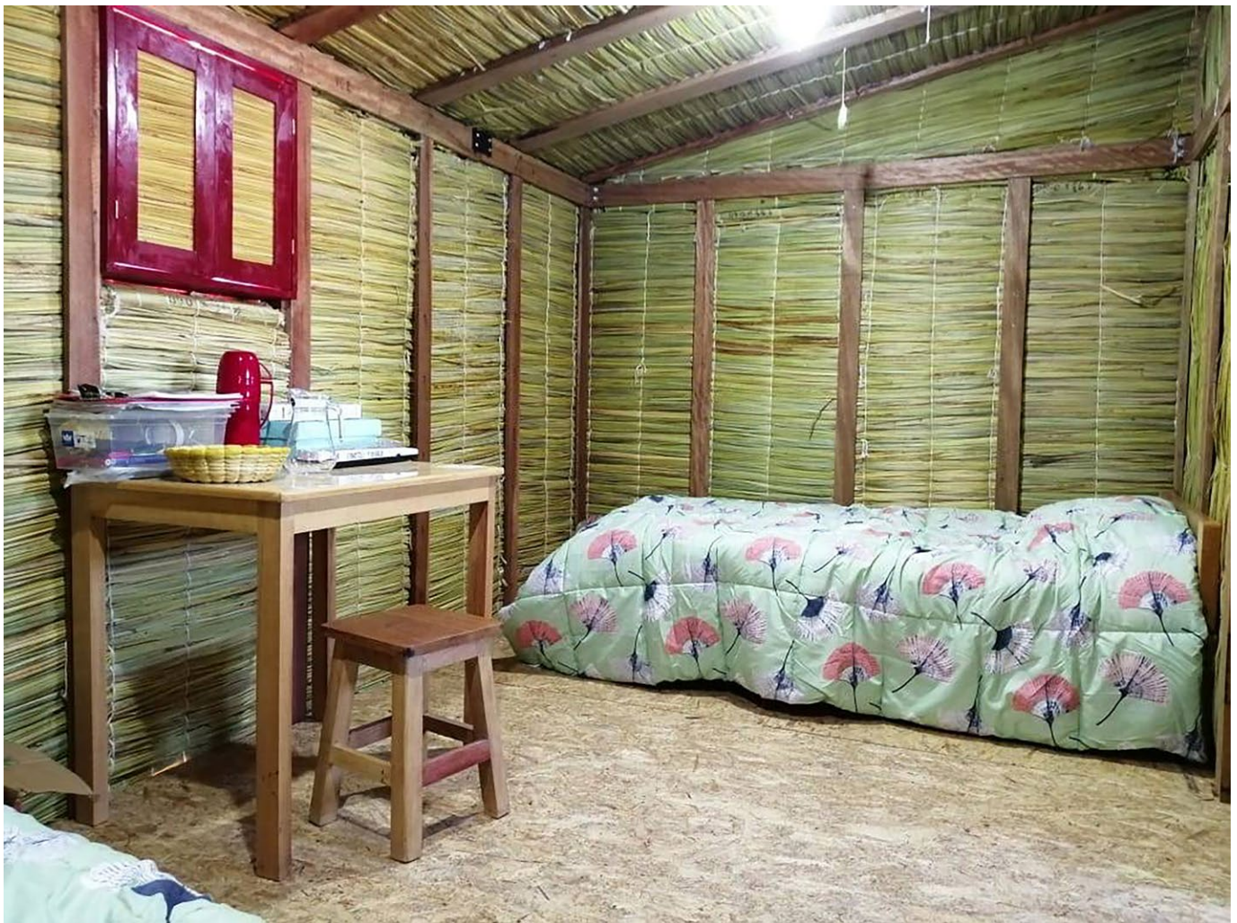
Figura 18. Interior de prototipo con paneles aislantes de totora expuestos.
