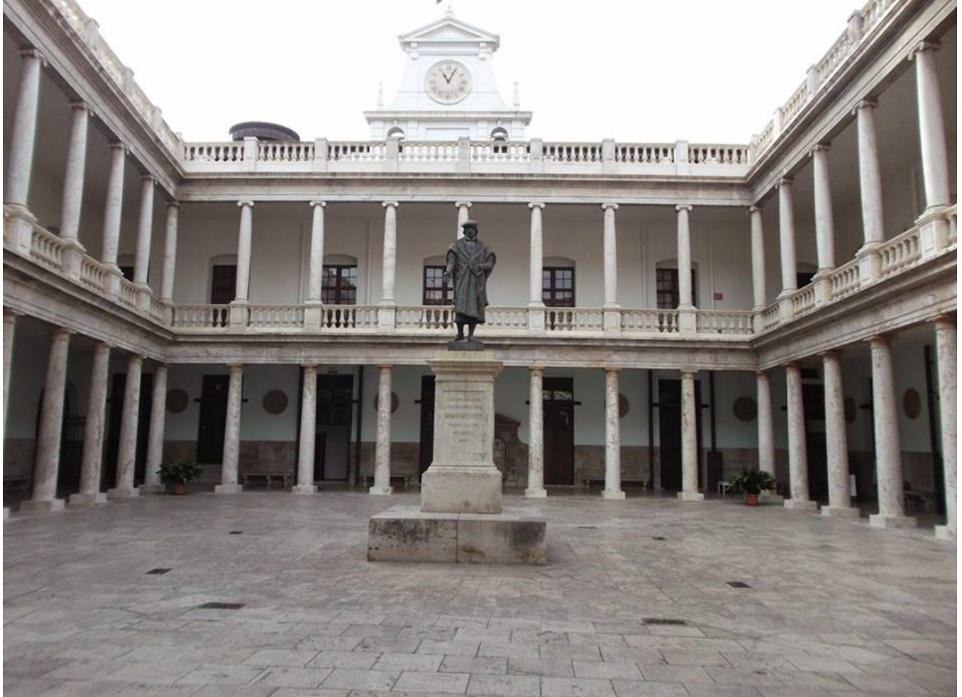
Fig 1. Claustro del edificio histórico de la Universitat de València. Estudi General.
