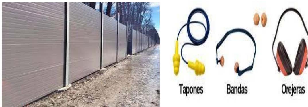
Figura 11. Colocación de barreras aislante y equipos de protección auditivo.
