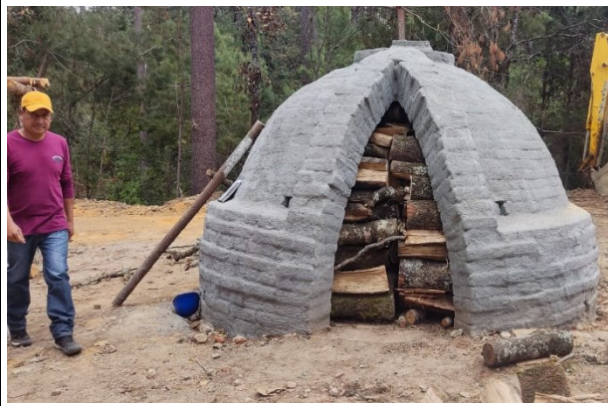
e) Resultado del acomodo de la leña antes del proceso de carbonización
