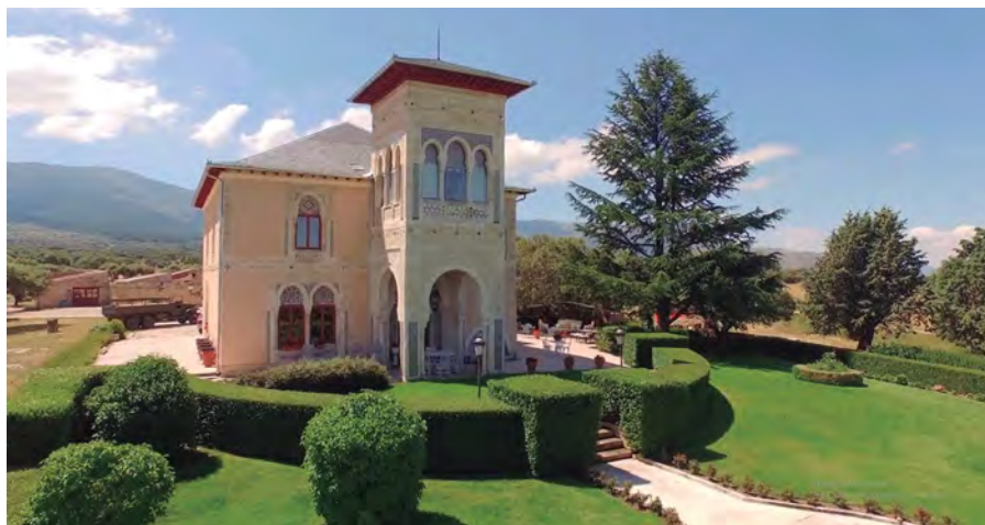
Fig. 12.- Izq. Imagen actual del exterior de la casa de La Lindaraja con parte de la cantería de Xifré en su fachada.
