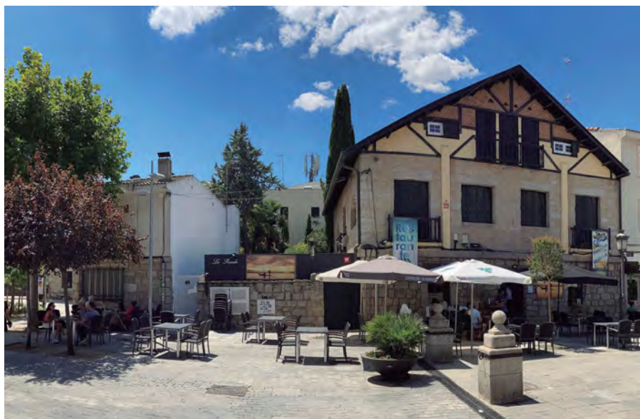
Fig. 4. Edificaciones actuales que, según Luis Cervera Vera, constituían el aposento de Felipe II en Torrelodones (fotografía del autor).
