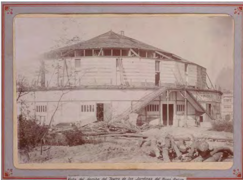
Foto 14. "Vista del derribo del teatro de los jardines del Buen Retiro" Servicio Fotográfico Municipal, ca. 1914 (Inv. 00006.760)
