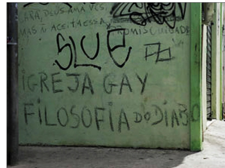
Figura 3 – Muro interno da CCNEI Fonte: Igreja, 2010.
