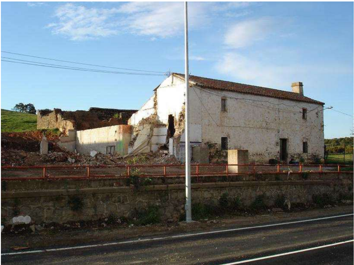
Restos de demolición y fachada de la última casa de colonos en la aldea de Venta Nueva (Santa Elena).
