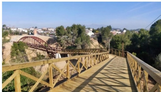
Figure 2. Course project of a pedestrian bridge at Can Quiseró (Masquefa) (year 2018/19) (Diputació de Barcelona, 2020)
