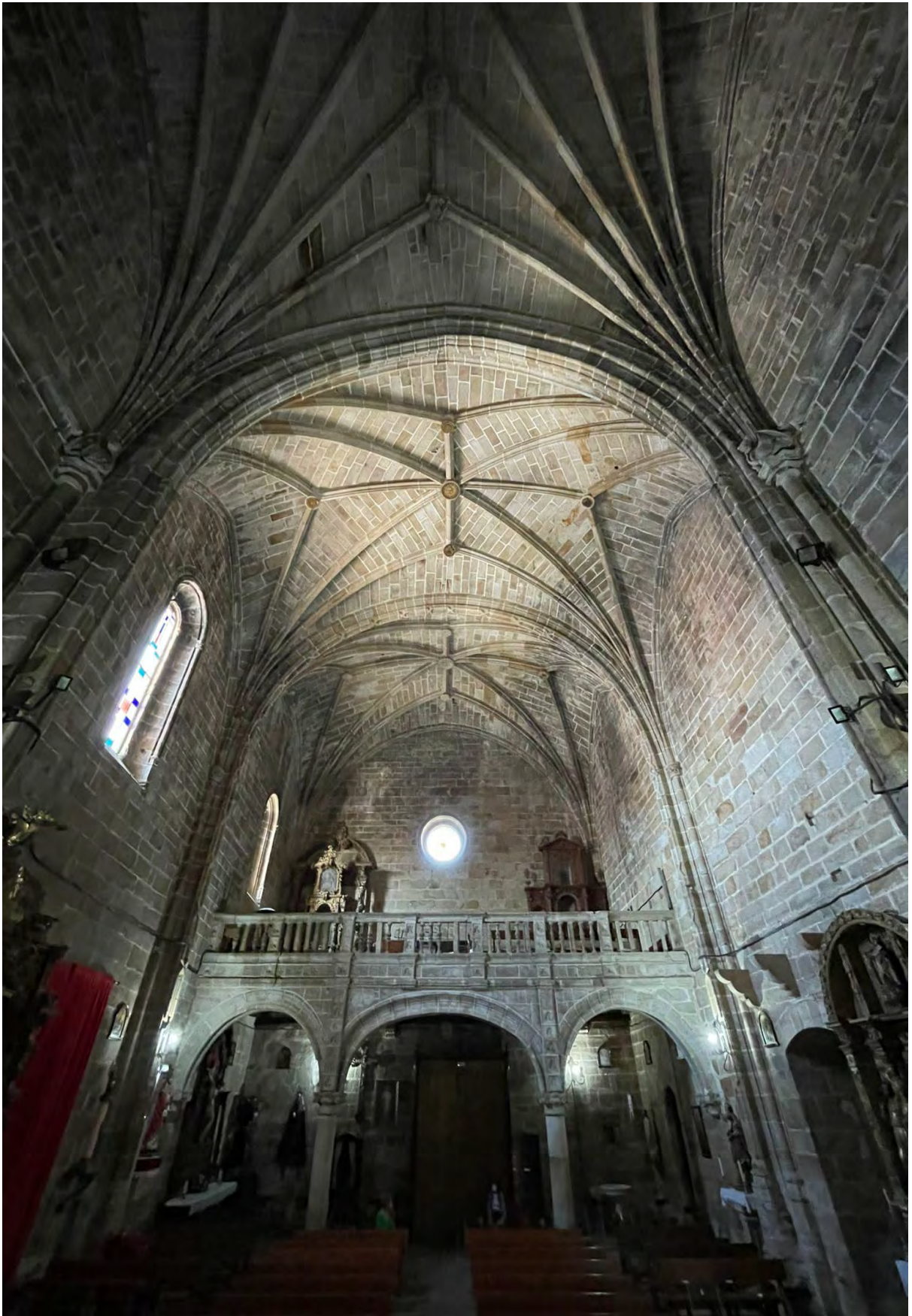
Detalle de las bóvedas
