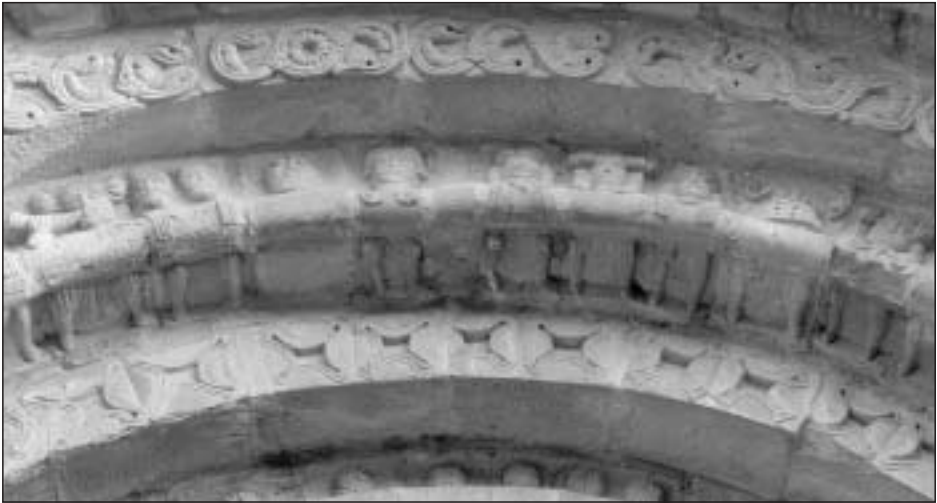
Fig. 6. Detalle de las dovelas 9 a 17
