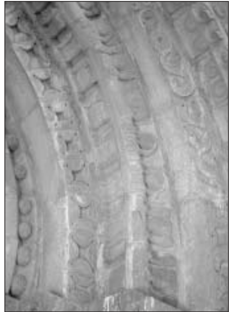
Fig. 8. Detalle de las dovelas 18 a 25
