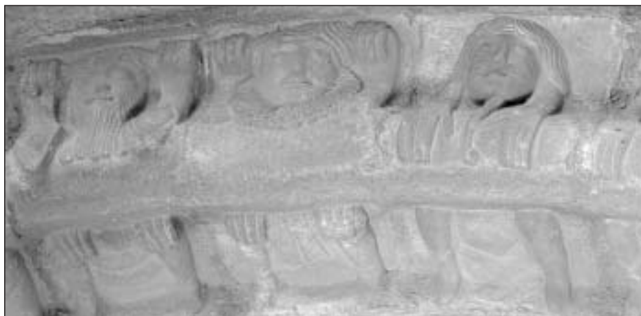
Fig. 30. Detalle de las dovelas 18, 19, 20 y 21
