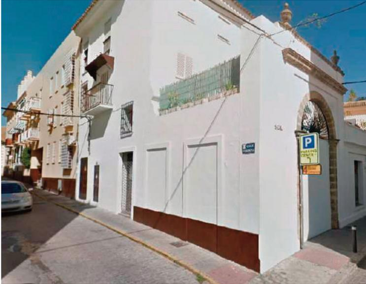
Fotografía de la esquina indicada de reciente apertura con dos huecos cegados, indicando, bien la relación funcional a través de la primera crujía con el edificio cuartelero, bien una simple formación para evitar alzado ciego y apeaar fachada antigua a la calle Sol.
