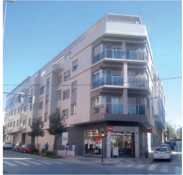
Imagen del edificio que ocupa en la actualidad parte del antiguo sanatorio.
