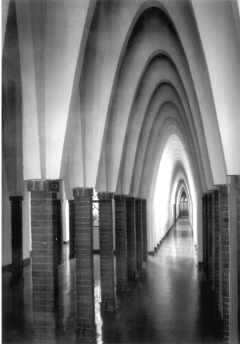
Figura 7. Arcos parabólicos en las galerías del Colegio Teresiano (1888-1889).
