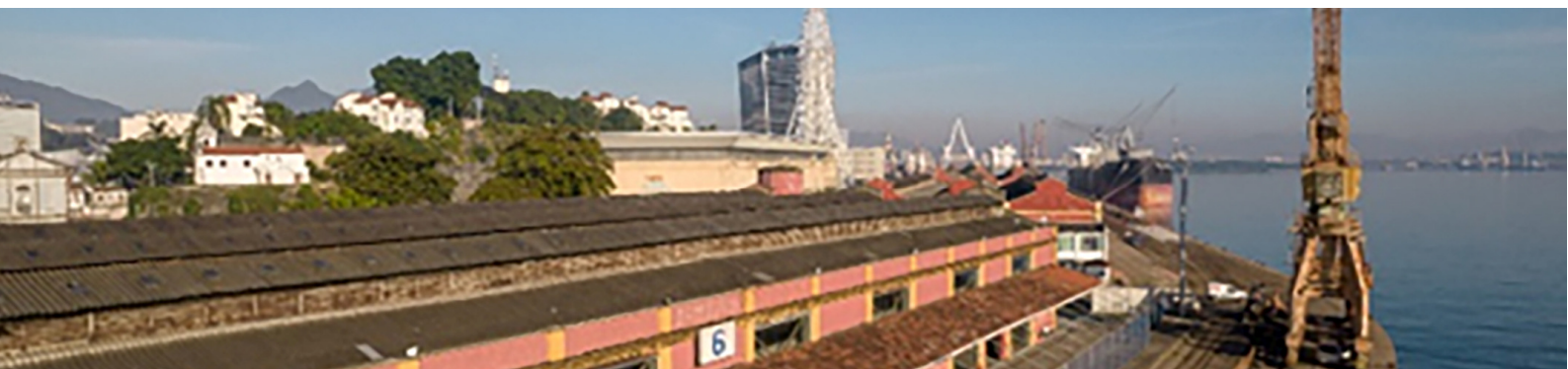
Armazém da Utopia . Rio de Janeiro-RJ, 2022, fotografia sem autoria (detalhe).
