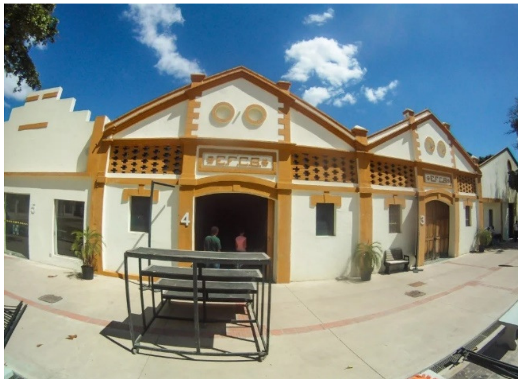
Figura 1. Galpão da Funarte em Belo Horizonte-MG reconvertido para teatro. 2010.
