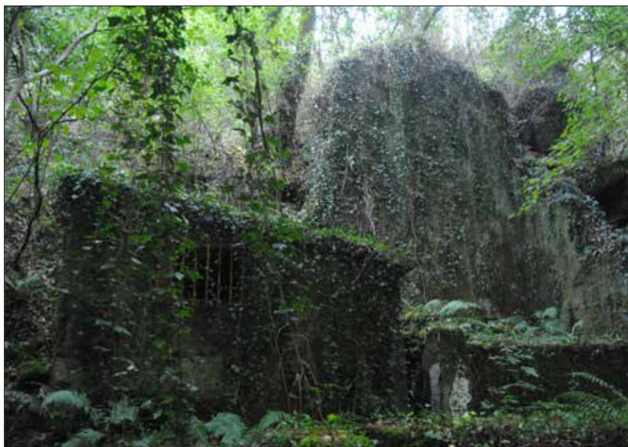
Vista do impresionante muro de contención da central. En 1º termo, a caseta da captación de rego moderna.
