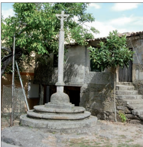
O Cruceiro do Loureiro antes das obras.
