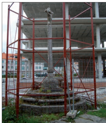
O Cruceiro do Loureiro despois das obras feitas ao seu carón.
