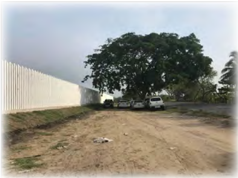
Fotografía 2. Transformación de predio para construcción de un edificio nuevo en la ciudad de Villahermosa Tabasco (México).
