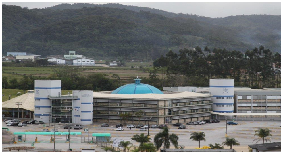
Figura 4: Prédio da Unifebe
