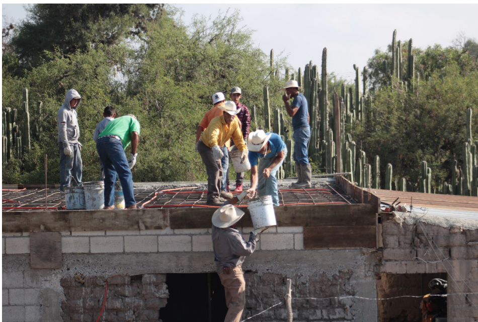
Imagen 1. Reconstrucción de cuartos: la placa de cemento del techo.
