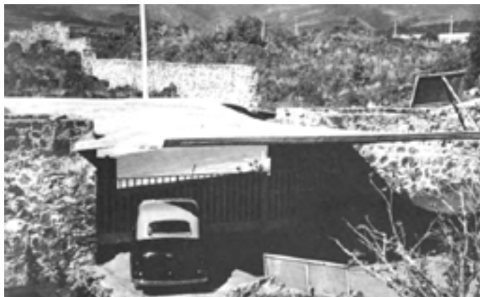
Figura 13. Cascarón conoidal con doble voladizo. Acceso de la casa Novedades No 3
