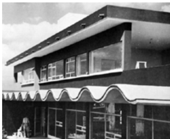
Figura 8. Fachada de la casa Romero, losas plana y sinusoidal
