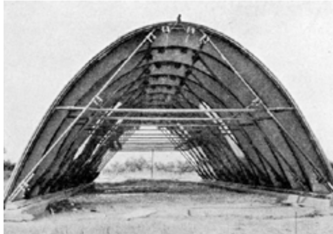
Figura 7. Bóveda de arcos catenarios con tela de yute y concreto diseñada por Kurt Billig
