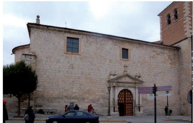
Fig. 19. Lado oriental de la actual iglesia de San Miguel de Peñafiel; de izquierda a derecha, el ábside semicircular y uno de los contrafuertes prismáticos esquineros, la portada con columnas, frontón y remates añadidos al acabar el siglo XVIII y el encuentro del muro perimetral con la torre más antigua.
