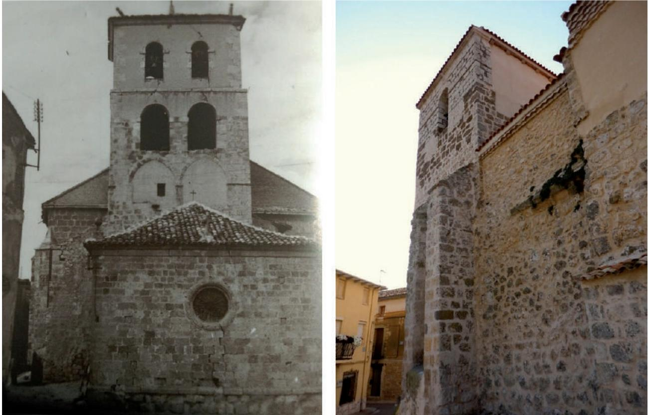
Fig. 3. Dos torres-Ábside en Peñafiel y cercanías: a) Desaparecida iglesia de El Salvador de los Escapulados de Peñafiel. b) Iglesia de San Cristóbal en Mérida, mostrando sus contrafuertes de apoyo y el muro superior a Poniente aligerado.
