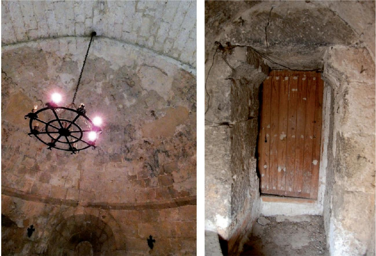
Fig. 12. a) Bóveda de horno del ábside de la primitiva iglesia románica, bajo la torre de San Miguel. Se aprecian los restos de pintura mural representando al Salvador, su primera advocación. b) Arco de ingreso desde la escalera de caracol al interior de la torre, con las ménsulas sustentando el dintel bajo el arco apuntado.
