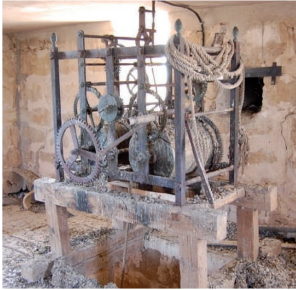
Fig. 6. Estado del reloj de Gumiel de Izán, adquirido en 1851. Fotografía 04/08/2009.
