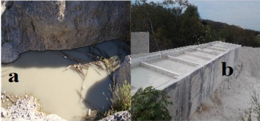
Figura 10. Laguna de efluentes del corte y abrillantado de mármol a cielo abierto: a) poza natural, b) estanque artificial.
