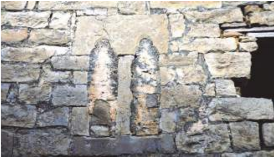
Ventanas de casa Txantxumena.
