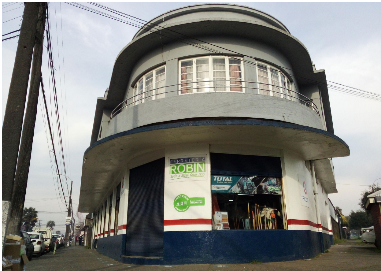
Figura 10. Arquitectura moderna en Pitruquén. Ferretería Robin. Fuente: Gonzalo Cerda Brintrup, archivo personal, 2023.
