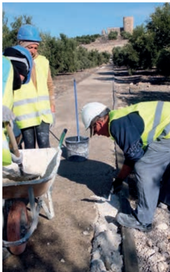
Foto 24. Trabajos de reparación del itinerario turístico del parque
