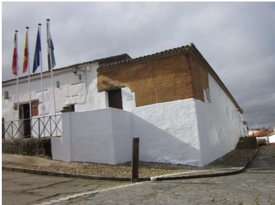
Exterior de la Casa de Santa María
