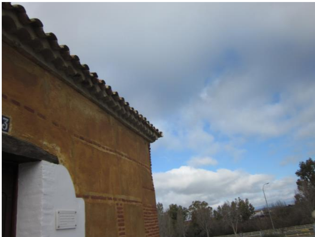
Casa de Santa María. Detalle de los materiales de construcción
