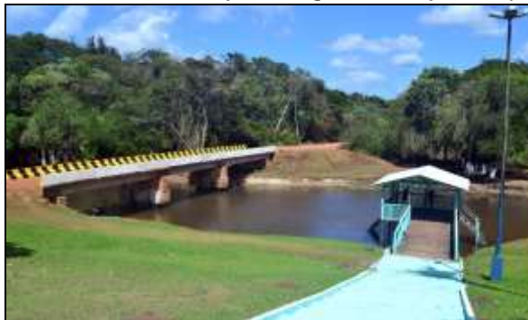
Figure 15: Ponte atual sobre o Rio Apeú, na Agrovila Macapazinho (Castanhal-PA)
