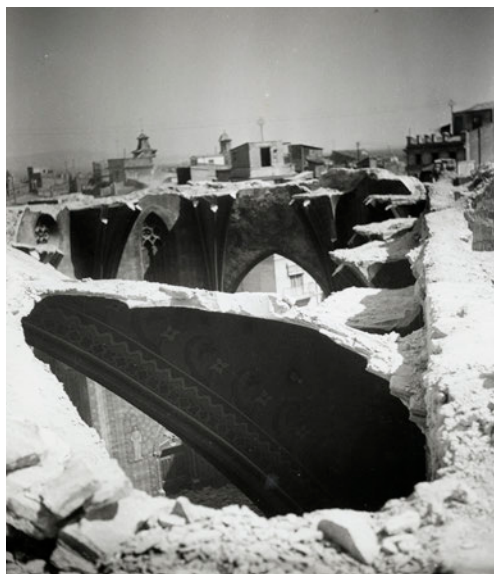
Il·lustració 7. Enderroc de l'arxiprestal de Santa Maria. Al buit que deixa un espai de la volta assolada es veu la seua estructura, feta per dues filades de rajoles posades planes.
