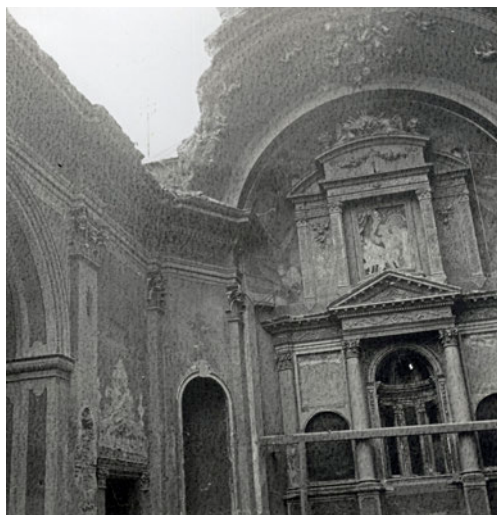
Il·lustració 5. Enderroc de l'església de la Sang. Estructura arquitectònica de l'altar major.
