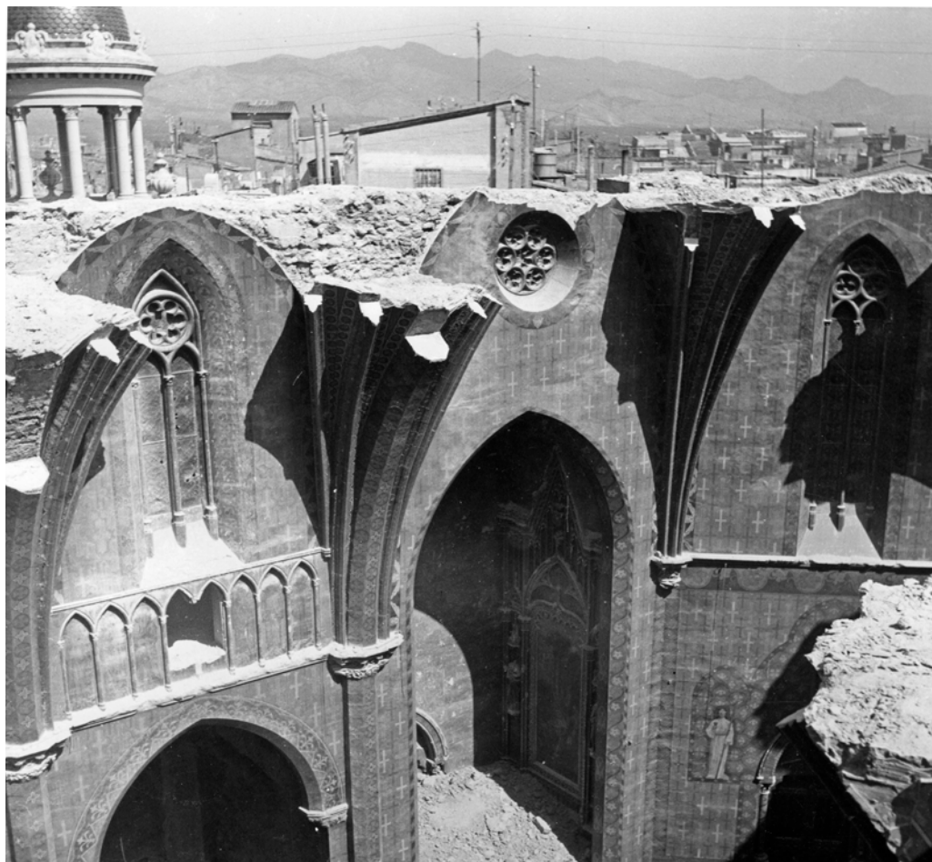
Il·lustració 9. Enderroc de l'arxiprestal de Santa Maria. Arc del creuer pel costat de l'Epístola.
