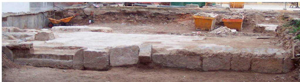
Il·lustració 18. Basament del mur nord del solar 11 del PGOU on apareixen el carreus reaprofitats per a l'edifici utilitzat com a magatzem.
