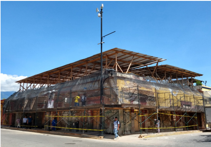
Figura 6 Proceso de rehabilitación de inmueble patrimonial
