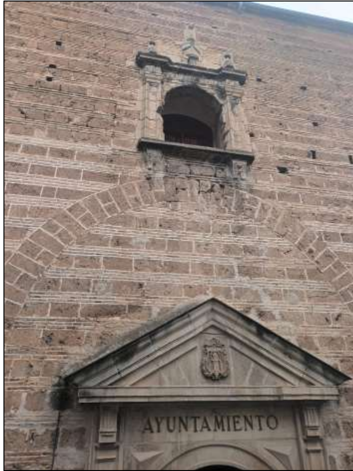
Arco de descarga y cambio de color de los sillares, donde se empieza la obra nueva en 1596. Foto: Matilde Escudero
