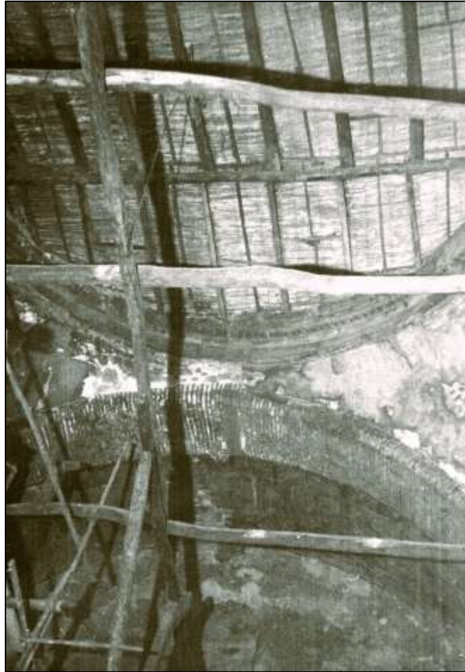
Anillo de la bóveda, arco toral de ladrillo y bóveda con casetones sobre el presbiterio. Fotografía de San Antonio de las obras de 1953.
