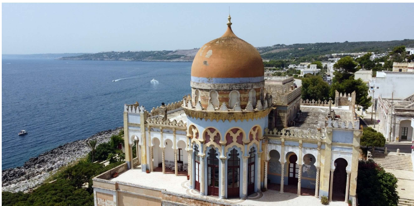
Figura 2. Campaña fotográfica de julio de 2021. Vista del frente Este de Villa Sticchi antes de las intervenciones de restauración. Imagen de los autores.
