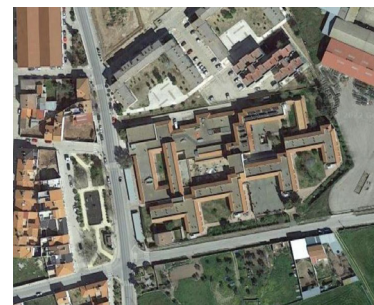
Figura 6. Visión aérea del CAMF Pozoblanco
