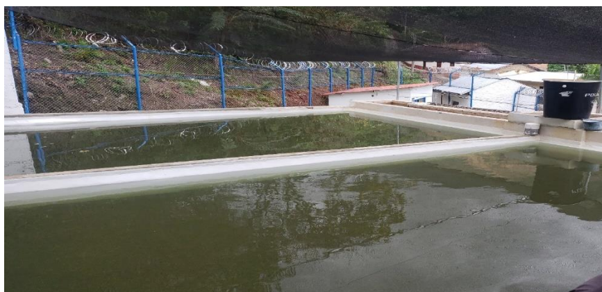
Figura 72. Tanques floculadores
