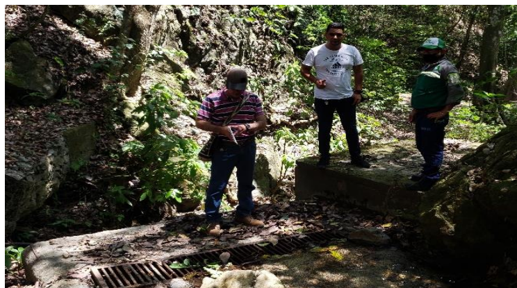
Figura 4. Bocatoma auxiliar quebrada el tigre
