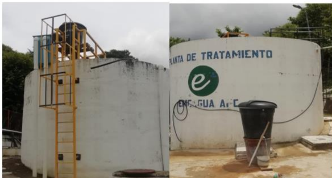
Figura 94. Tanques floculadores
