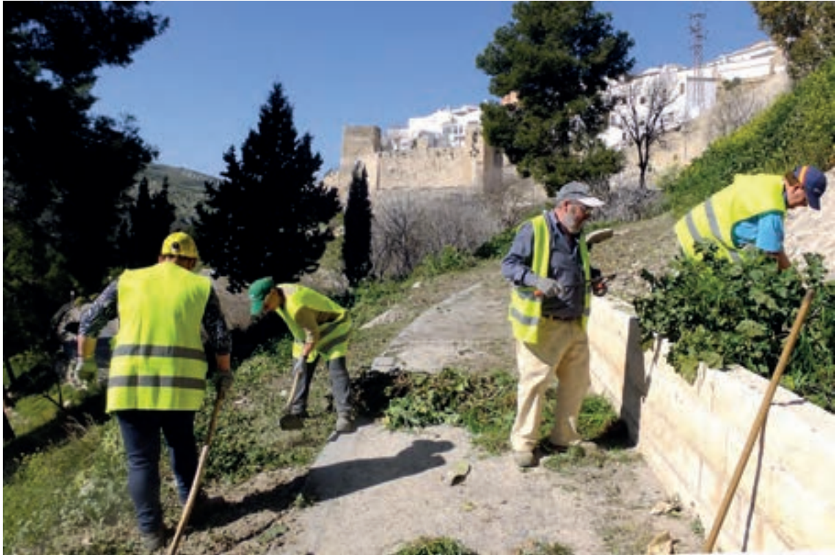
Lám. 73 Trabajos de limpieza vegetal en la ladera sur
