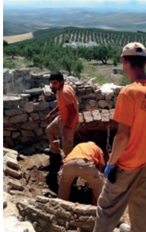
Trabajos de consolidación en el horno de pan del siglo XIV
