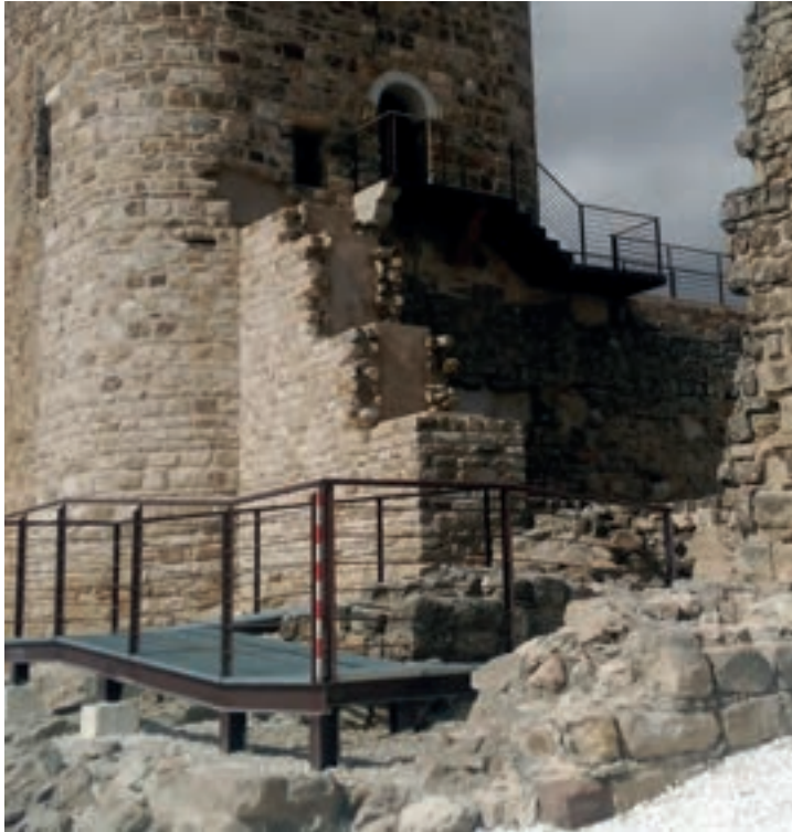
Detalle del acceso al castillo con la pasarela de tramex
