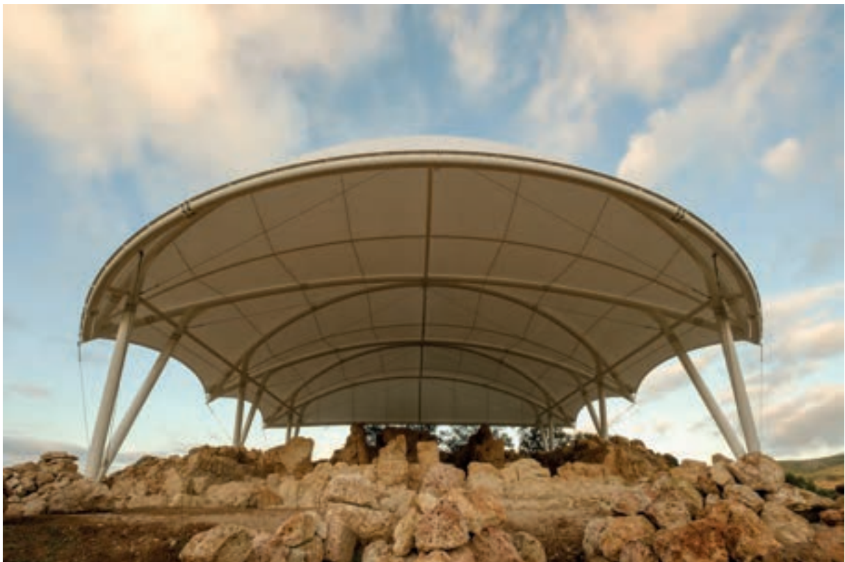
Lám. 9. Cubierta del Cerro de la Merced.
