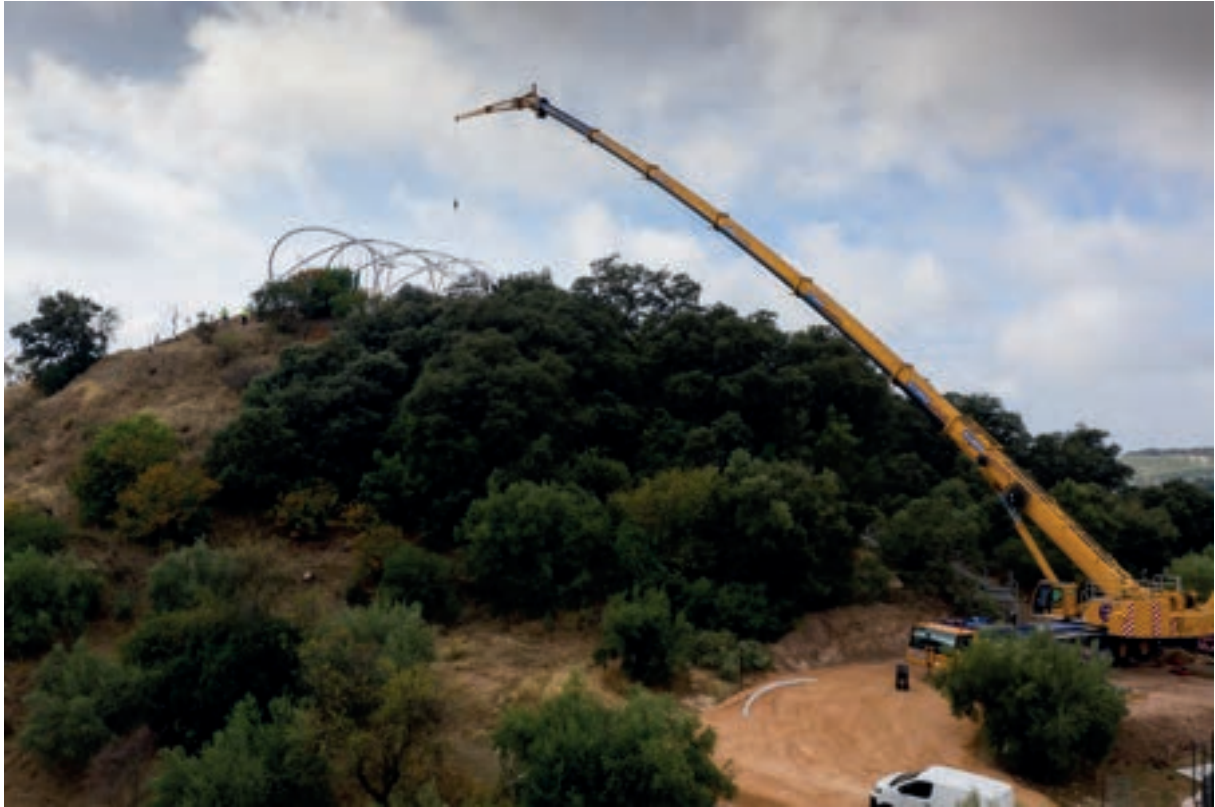
Lám. 8. Proceso de montaje de la cubierta del Cerro de la Merced.
