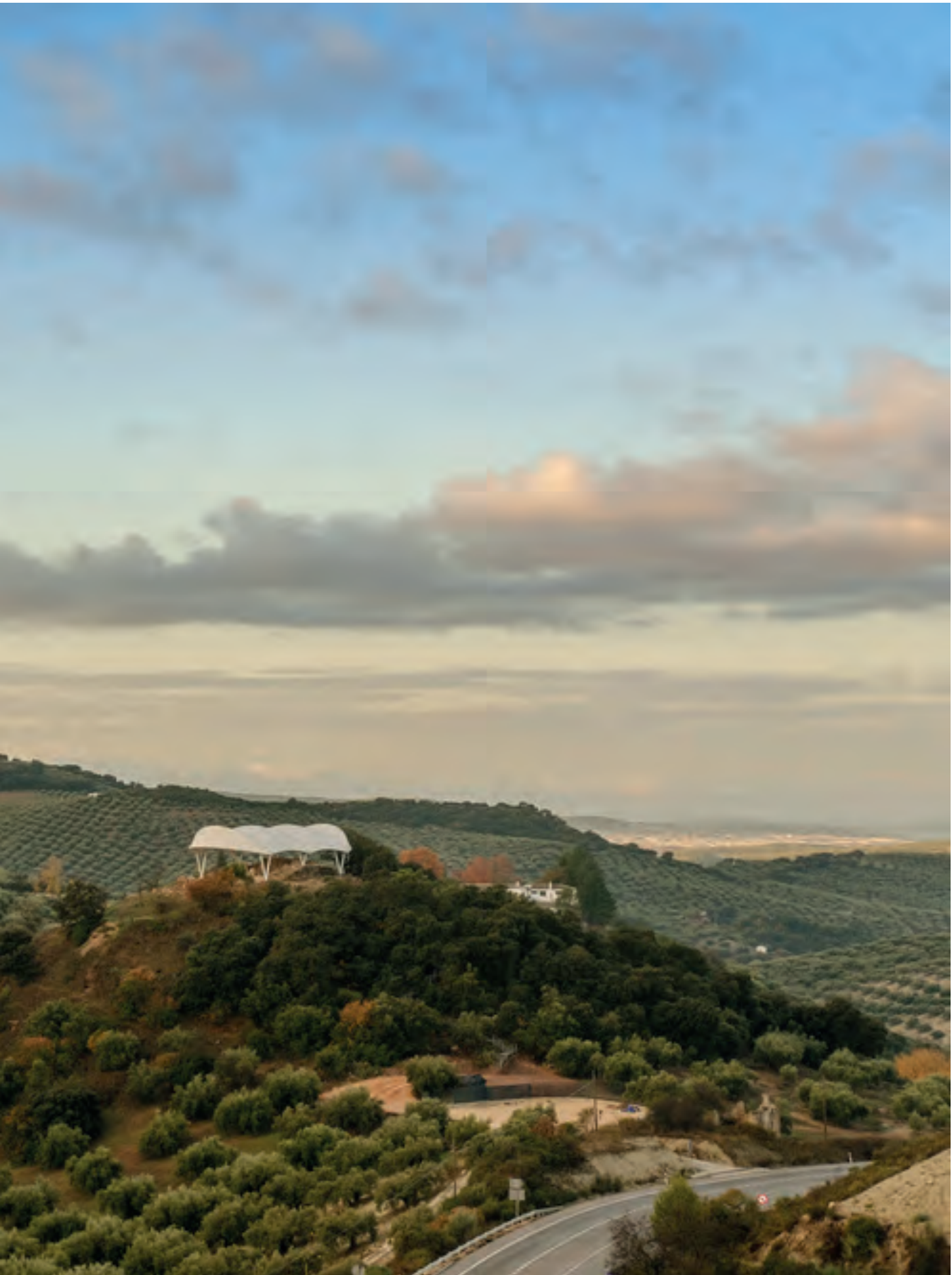
Lám. 7. Cubierta del Cerro de la Merced.
