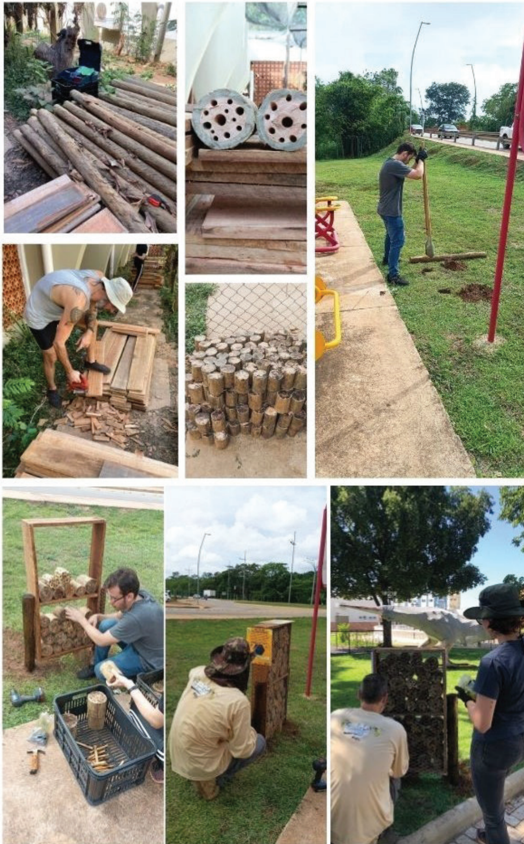
Figura 2. Preparação, construção e exemplos de instalação dos hotéis em áreas verdes públicas de Rondonópolis, Mato Grosso, Brasil, pelos participantes do projeto de extensão “Hotel de polinizadores: Tornando as áreas urbanas amigáveis para abelhas e vespas”.
