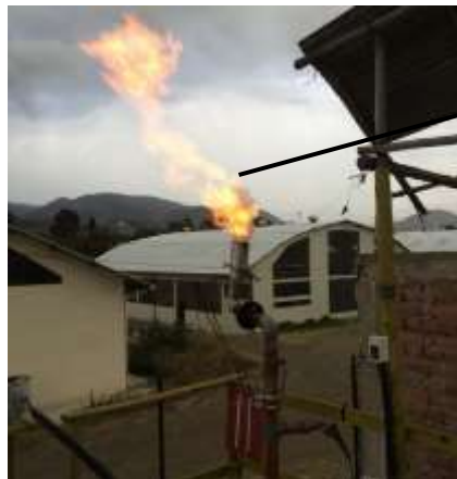
Figura 179. Combustión del gas pobre. Fuente: Propia
