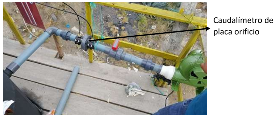
Figura 13. Instalación del medidor de caudal 1 PVC. Fuente: Propia
