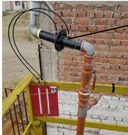
Figura 14. Instalación del medidor de caudal 2 acero. Fuente: Propia
