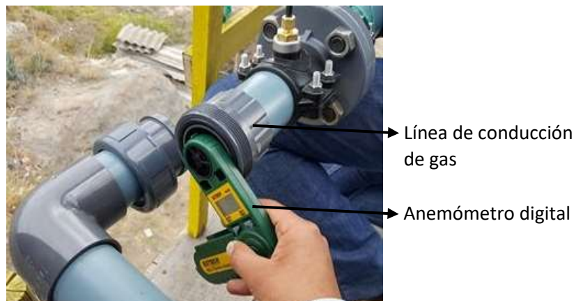
Figura 2. Medición de la velocidad de filtración. Fuente: Propia
